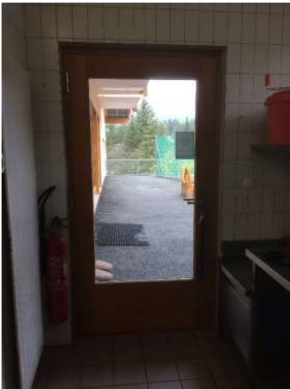
Photo 8 Porte d'accès extérieure de la cuisine
