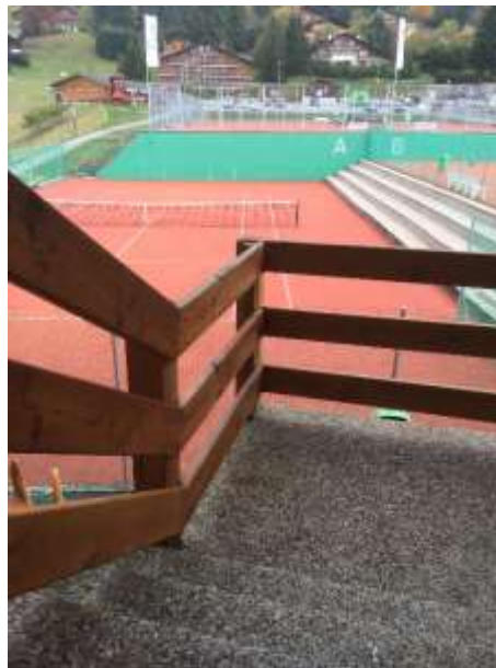
Photo 10 Escalier et palier intermédiaire
