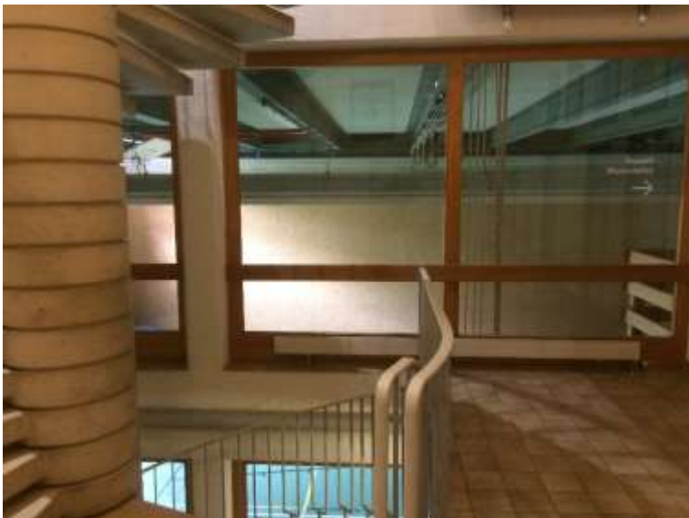
Photo 15 Baie vitrée au niveau inférieur
