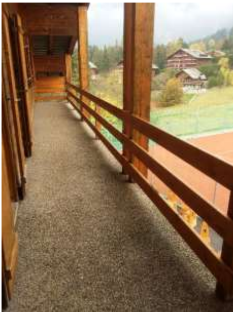
Photo 9 Coursive d'accès aux chambres et dortoirs
