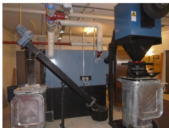
Chaudière à bois actuelle à modifier
