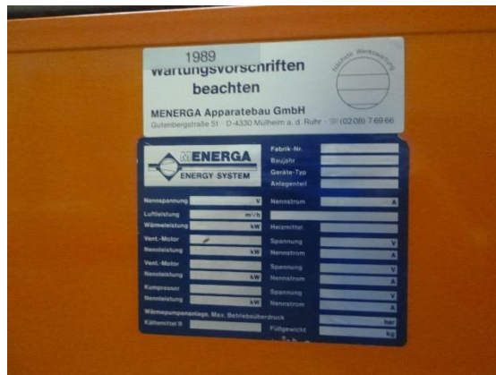
Installation datant de 1989
