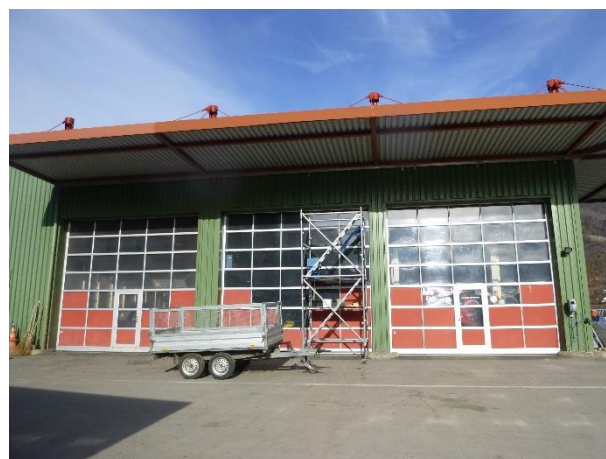
Façade Sud, atelier réparations
