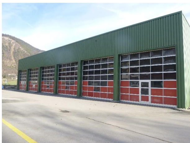
Façade Ouest, garages véhicules
