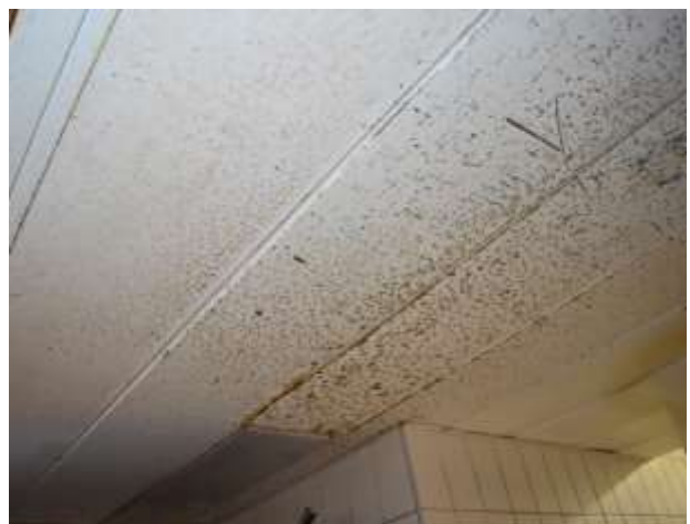
Tôle de ventilation
